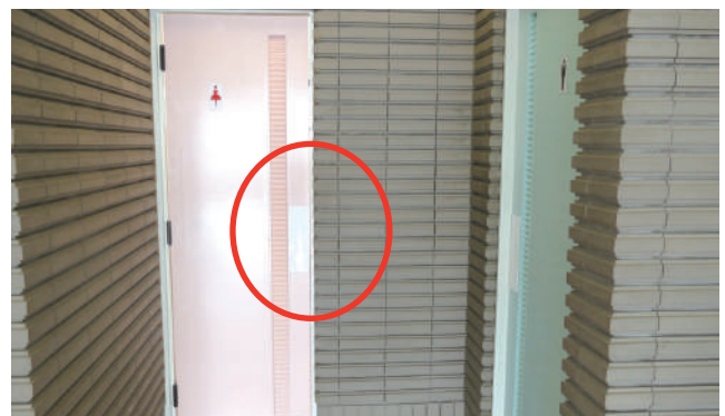
トイレ出入口ドアノブ撤去（接触緩和）
